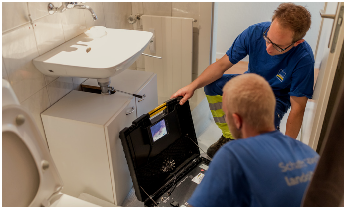
Schlussprüfung der Dichtigkeit mit dem Kanalfernsehen.
